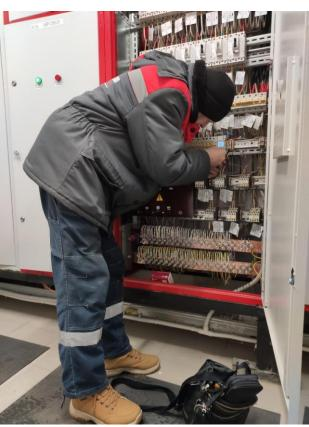
• Выполнена установка астрономического реле включения наружного освещения и освещения в МОП по адресам: ул. Производственная, д. 12 к.1, д. 12 к.2
